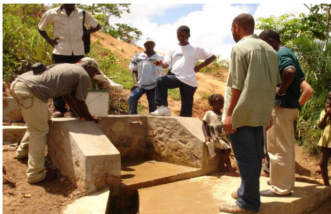
Captage d'eau réalisé par la communauté de Sainte Suzanne
