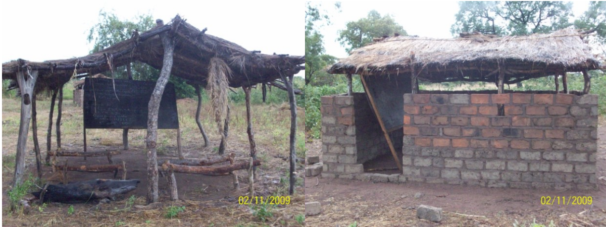
Les deux hangars des trois pour l'école de Ndoheuri pour laquelle Esso propose la construction de la maison du Directeur
